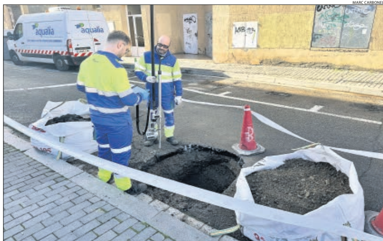
Tècnics d'Aqualia van comprovar que no hi hagués fugites d'aigua a les canonades pròximes.
