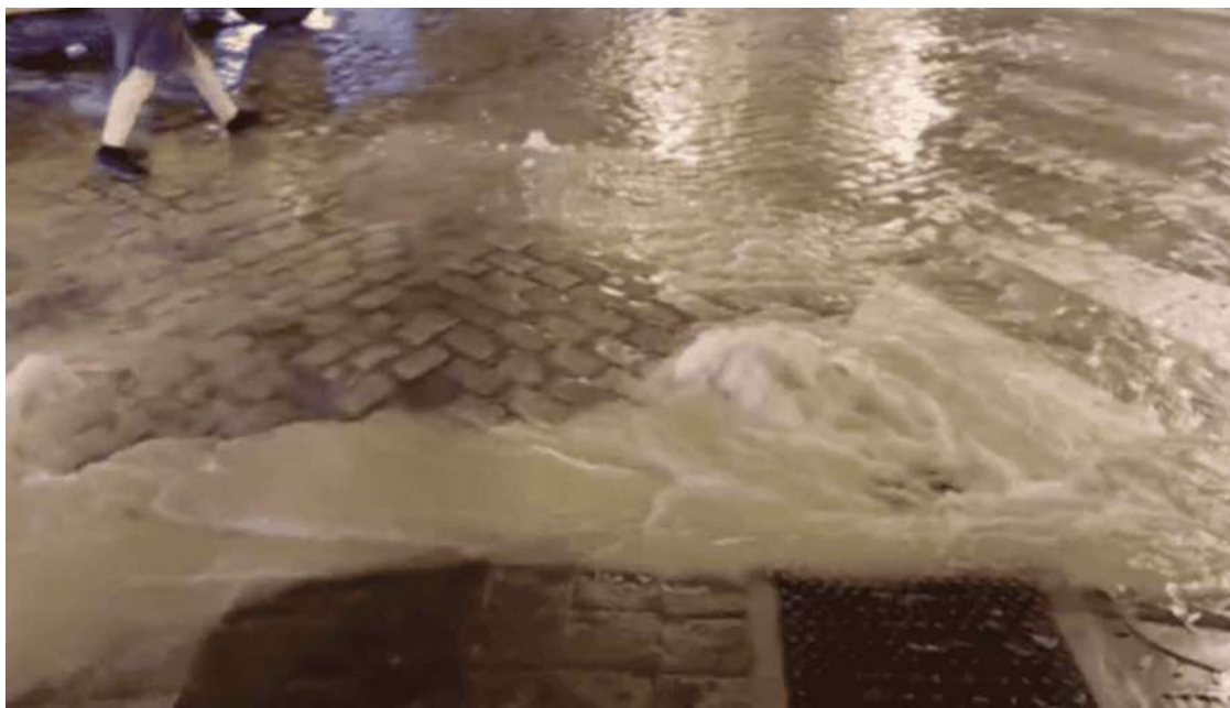
Agua a borbotones tras la rotura de una tubería al inicio de la calle Honda.
