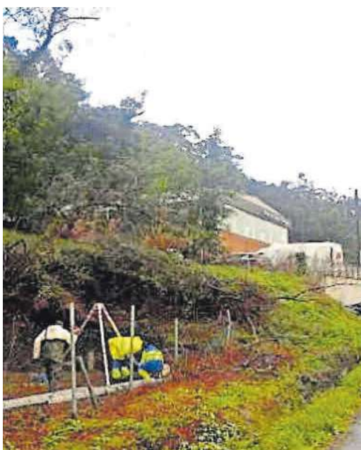
Operarios de la UTE trabajando en la captación de Angueiro. | FdV
