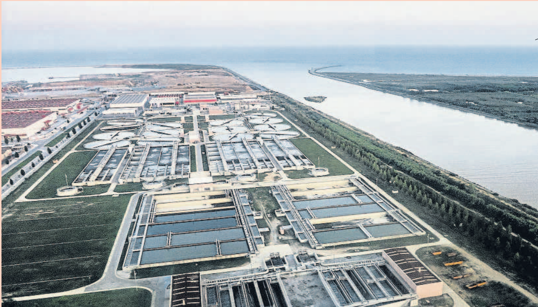
La depuradora de Aiguà de Ter Llobregat en El Prat
